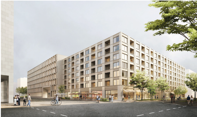
Der Wohnbau schließt als Blockrand zur Topografie des Terrors hin ab
