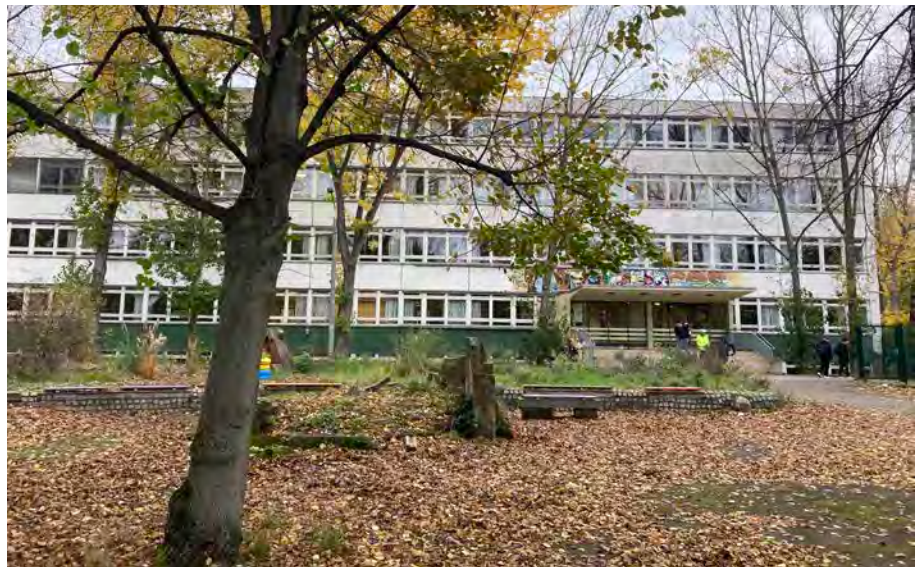
Foto: Schulgebäude, Haus 2, Blick vom Schulhof
