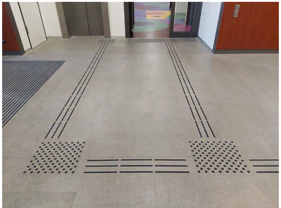
Abbildung: Beispiel für ein Blindenleitsystem mit Aufmerksamkeitsfeldern (gepunktet) und Leitlinien, wie es an den Haupteingängen der Schule und Sporthalle eingesetzt werden soll.
