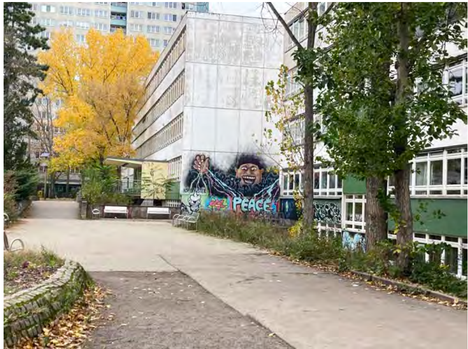
Foto: Schulgebäude, Blick vom Schulhof - im Vordergrund Haus 2, im Hintergrund Haus 1
